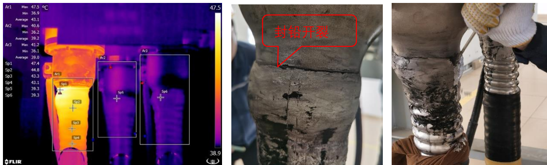
图 1 GIS 终端尾管发热（封铅密封）
