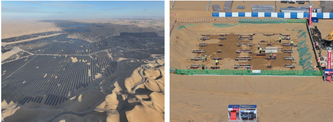
图 2 现场无人机智能巡检
